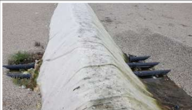
Passage des drains entre les subdivisions de D3
